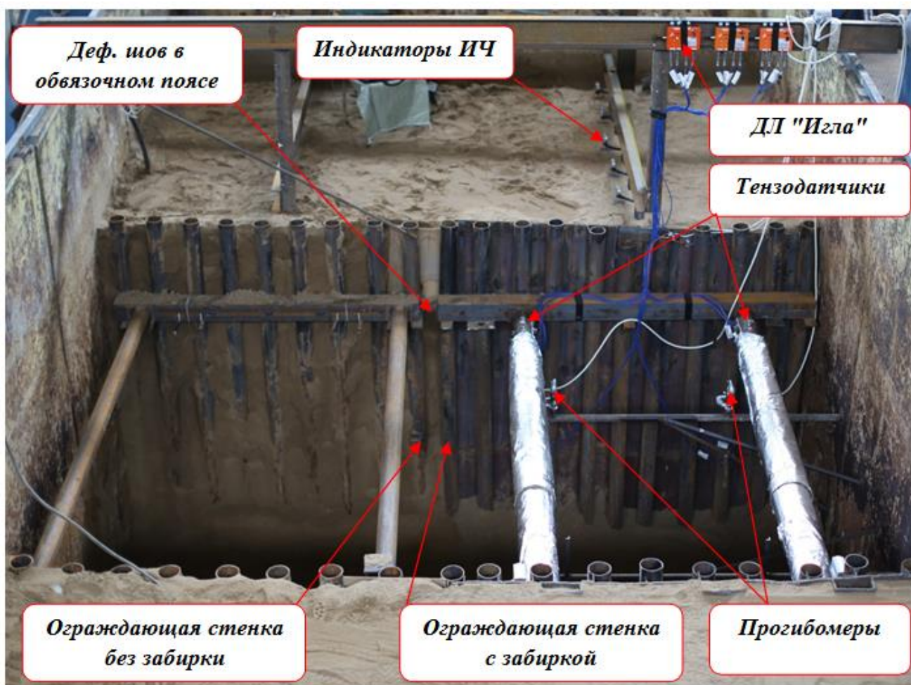
Рисунок 1 - Общий вид опытного котлована и установленного оборудования
