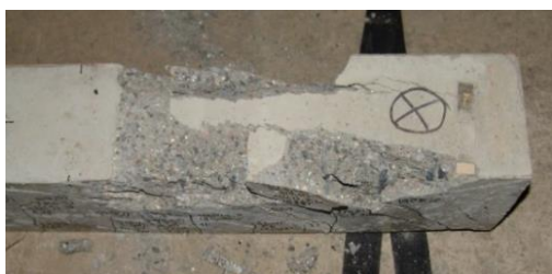
Рисунок 4 – Характерное разрушение балок групп Б4, Б5, Б6
