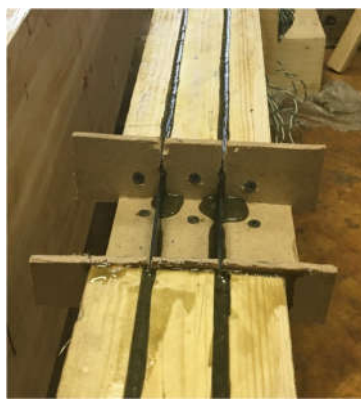
Рисунок 11 – Усиление балки в зоне дефекта
