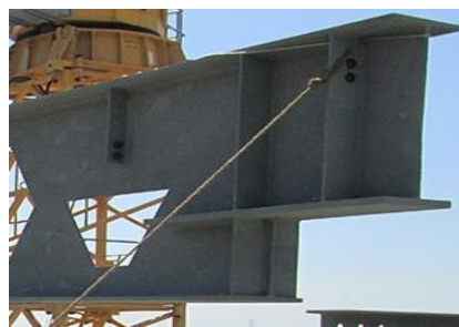
Рисунок 5 – Шарнирное сопряжение перфорированных балок: а) опирание сверху б) с «подрезкой» (консольным выпуском)
