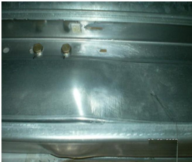
Рисунок 11 - Вмятина, образовавшаяся в нижней сжатой полке профиля ригеля рамы
