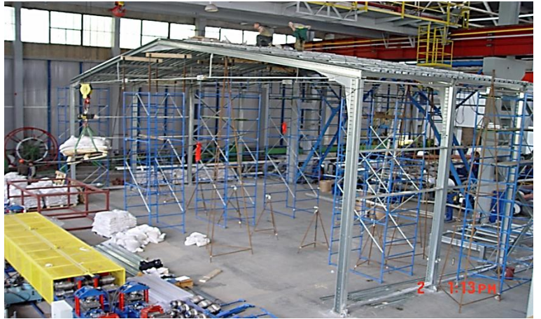
Рисунок 9 - Общий вид испытываемой конструкции со страховочными подмостями
